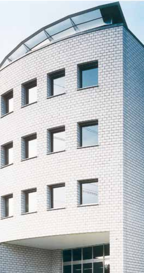
Läuferverband Steinhöhe 14 cm
